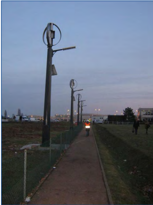
Sistema Windelux® recientemente instalado en el Aeropuerto de Orly (París – Francia). El banco de baterías y los reguladores del sistema se encuentran en el interior de poste.
